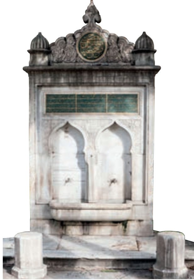
Erenk y İstasyon eşmesi.
