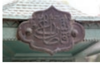
İçerenköy'de cadde üstünde bulunan demir döküm çeşmenin dört ayrı yüzünde Osmanlıca, "Kayış Dağı Suyu, sene 1926, numara 1. Şehremâneti" yazılıdır. Daha sonra çivilenen küçük tabela ile "İstanbul Sular İdâresi" ibâresi eklenmiştir.
